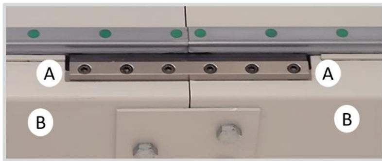
Abbildung 6. Stellen mit möglicher Rissbildung
