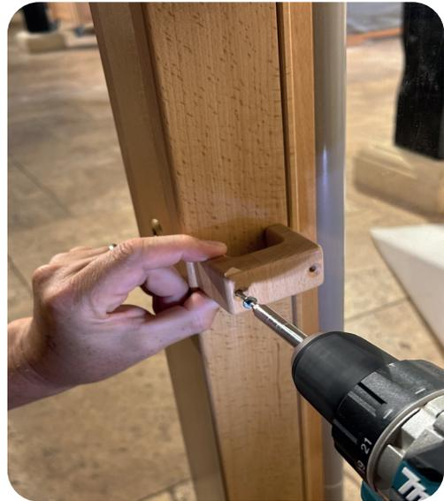
2. Verschrauben Sie den Handschalterhaken mit den beiliegenden Schrauben.
