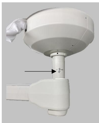
Bild 3 Richtig: Befestigungsschraube vorhanden und keine sichtbare Beschädigung
