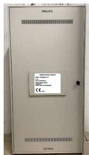
Figure 3. Armoire à filtration
