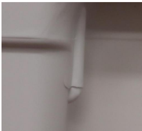
Exemple de fissure sur une coque d'emballage Intellipack
